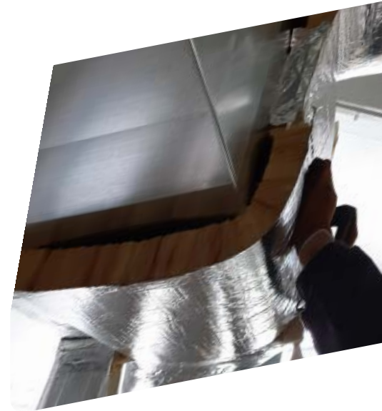
Sellado exterior del aislamiento con cinta de aluminio.
