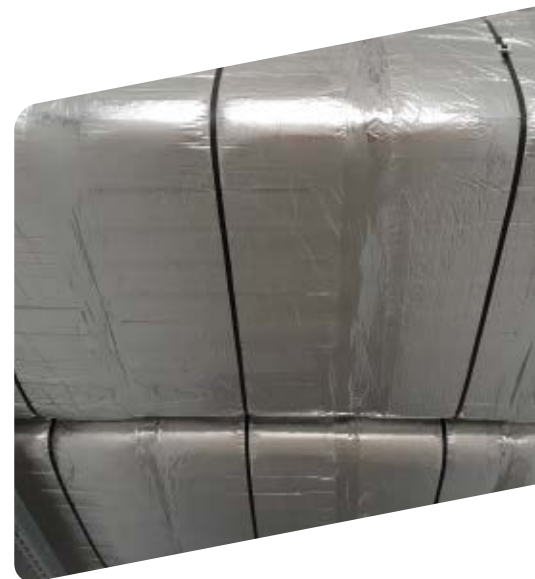
Fijación mecánica con bridas o flejes del aislamiento exterior conductos metálicos.
