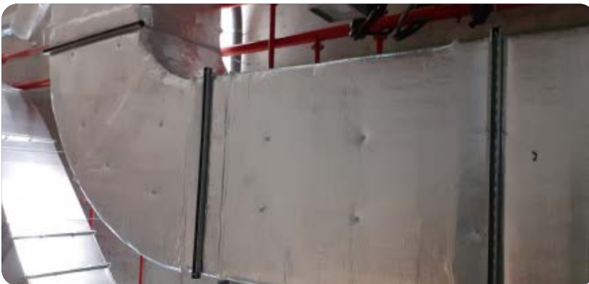
Fijación mecánica con pines electrosoldables del aislamiento exterior conductos metálicos.
