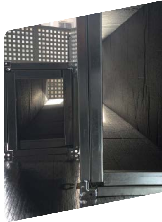
Aislamiento con CLIMLINER Roll G1 interior de conducto rectangular.
