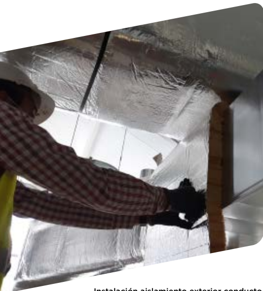
Instalación aislamiento exterior conducto metálico con manta continua.
