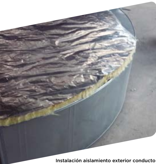
Instalación aislamiento exterior conducto metálico con manta por caras.
