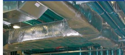
La solución ISOVER para el aislamiento por el exterior de conductos metálicos. CLIMCOVER proporciona un óptimo aislamiento térmico y previene el riesgo de condensación en conductos metálicos.
