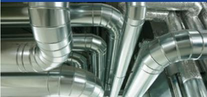
Las coquillas ISOVER para el aislamiento de tuberías HVAC. Las cubretuberías CLIMPIPE proporcionan altos niveles de aislamiento térmico y previenen la condensación en las tuberías.
