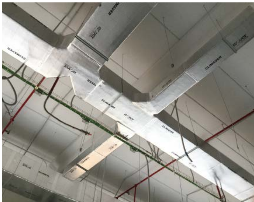
Instalación conductos Sea CLIMAVER®. Zapato MTR.
