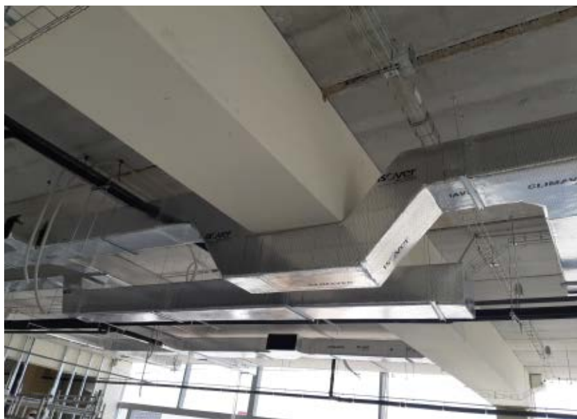
Instalación de conductos Sea CLIMAVER®. Paso de viga MTR.
