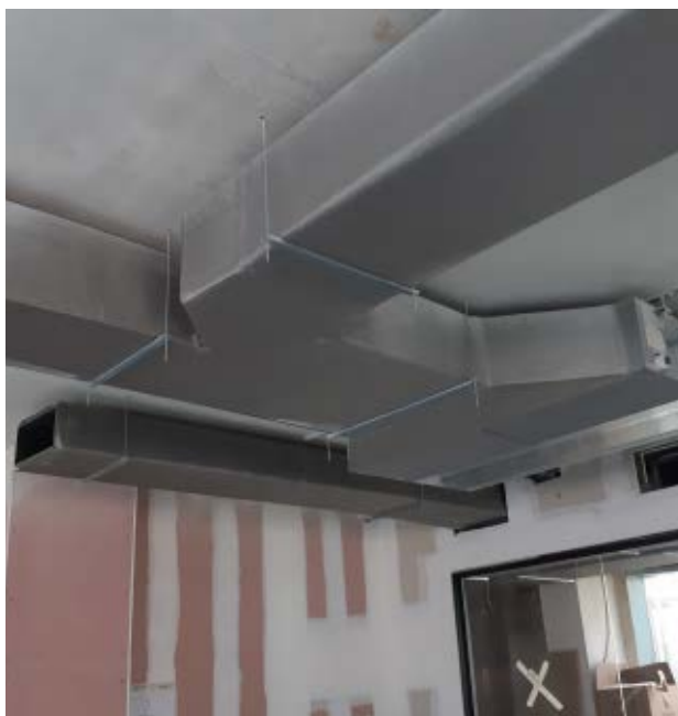
Instalación conductos Sea CLIMAVER®. Embocadura a máquina reducción a dos caras MTR.
