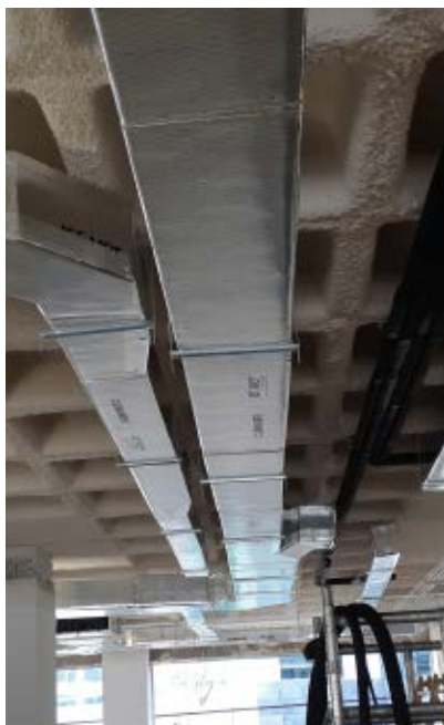
Instalación de conductos Sea CLIMAVER®. Reducciones MTR.
