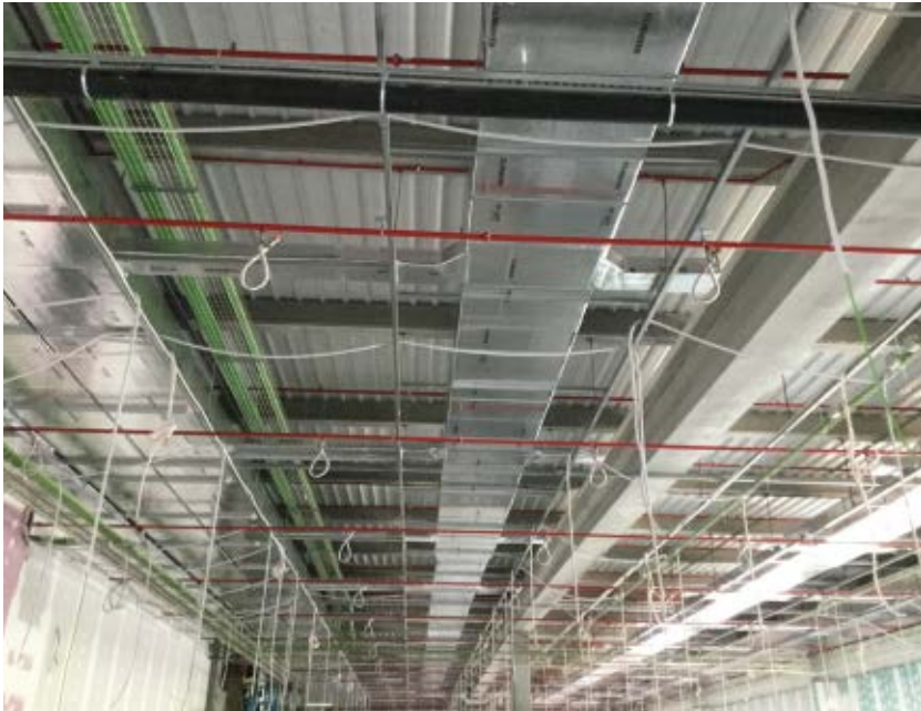
Instalación de conductos Sea CLIMAVER®.
