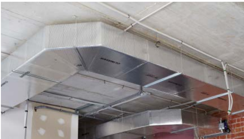
Instalación de conductos Sea CLIMAVER®. Codo MTR.
