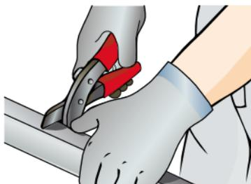
La unión mecánica de perfiles metálicos entre sí se realizará por medio de tornillos TRPF o punzonándolos mediante grapadora especial cuando sea necesario.
