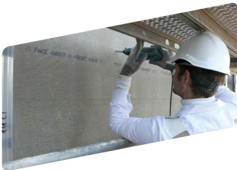
Se recomienda que la distancia entre las juntas verticales de dos hileras de placas consecutivas sea la mitad de la longitud de las placas. Una misma placa no deberá ser fijada a dos perfiles distintos en la línea vertical.
