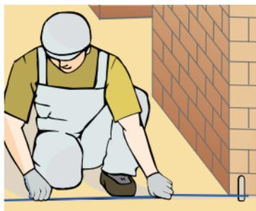
Una vez replanteado el tabique en suelo y techo se procederá a fijar los "raíles" o perfiles metálicos que componen los anclajes horizontales.
