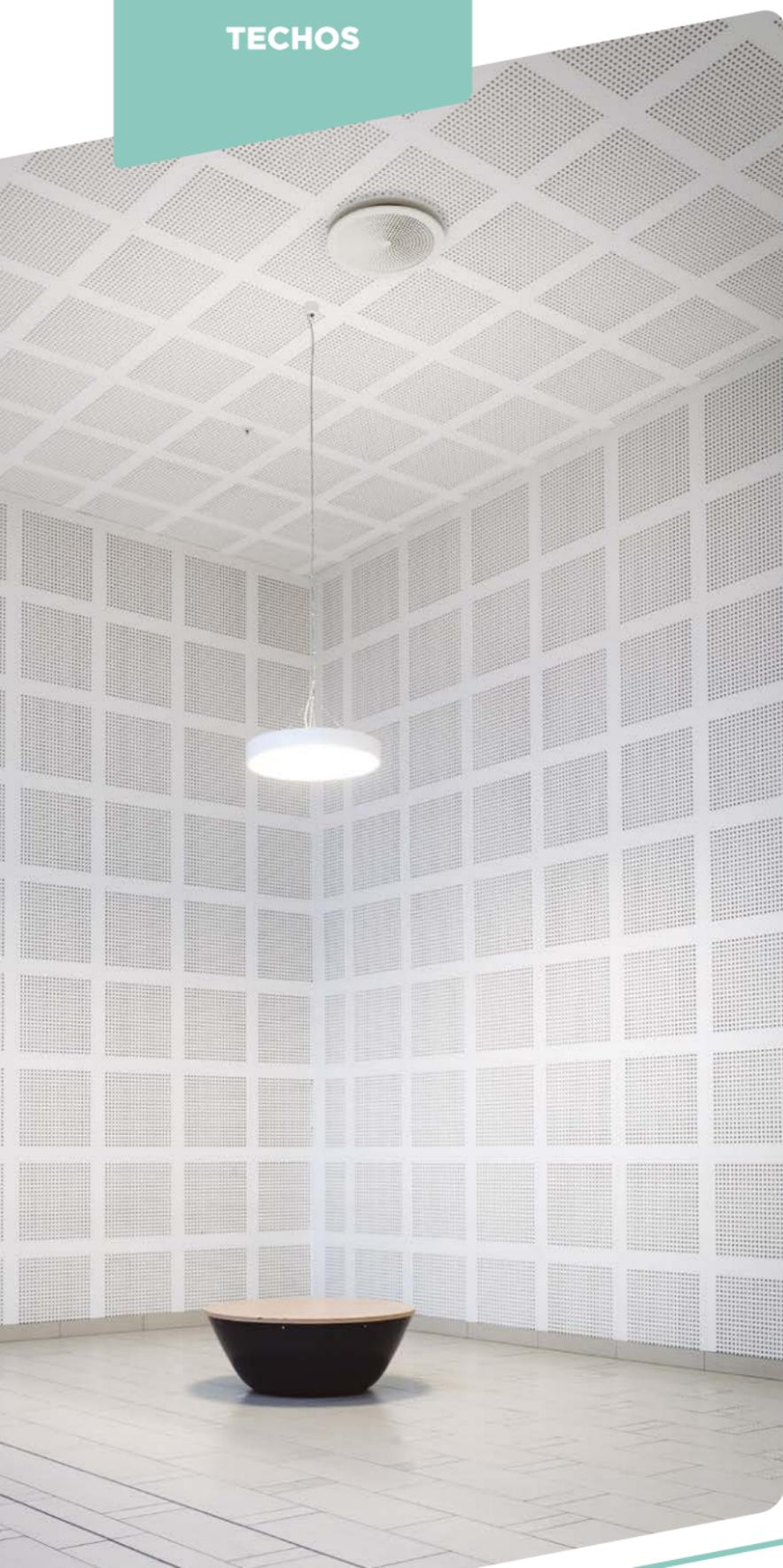
Los techos suspendidos **Placo**<sup>®</sup> están formados por placas de yeso laminado o placas de escayola ancladas a una estructura metálica fijada a los elementos estructurales del edificio.
