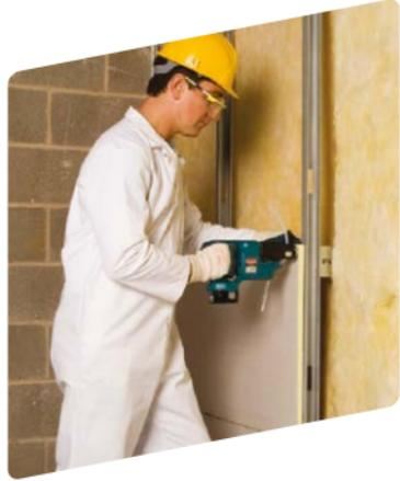
Se fijan horizontalmente a la estructura metálica con montantes modulados como máximo a 600 mm. Las placas de las capas interiores se fijan a la estructura metálica usando tornillos HD únicamente en su perímetro.
