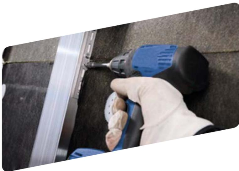
Los perfiles verticales se fijan al ala larga de las ménsulas mediante los tornillos-ménsula. El número de tornillos de unión entre ambos debe ser como mínimo dos en los puntos móviles y cuatro en los puntos fijos, pudiendo ser superior si los cálculos del sistema lo requieren.
