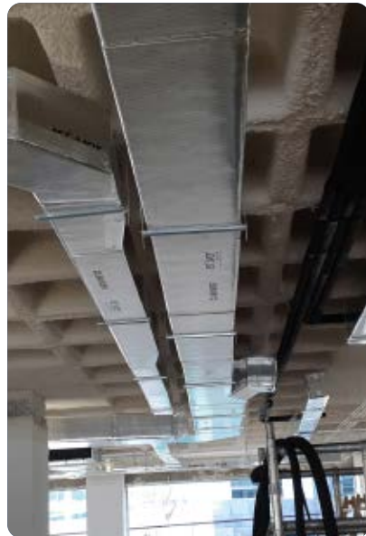
Instalación de conductos CLIMAVER®. Reducciones MTR.
