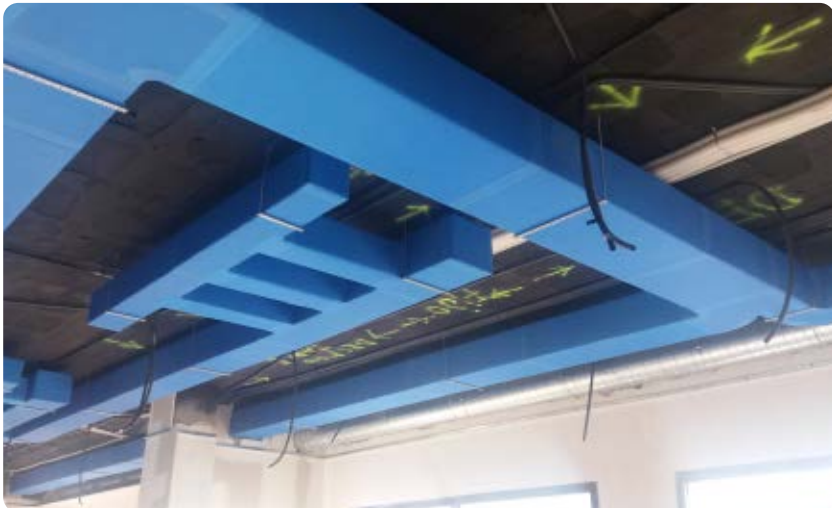
Soportación de instalación de ventilación CLIMAVER® A2 deco.
