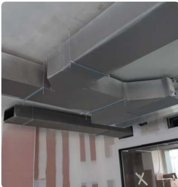
Instalación conductos CLIMAVER®. Embocadura a máquina reducción a dos caras MTR.
