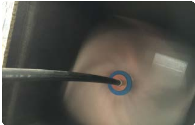
Limpieza por cepillado de un conducto CLIMAVER®.
