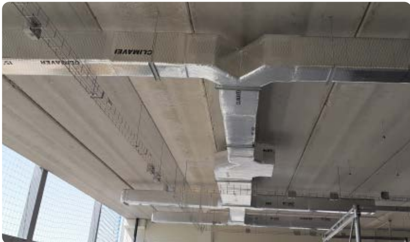
Instalación de conductos CLIMAVER®.
