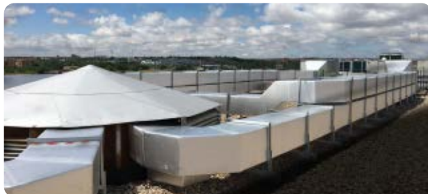
Instalación de conductos CLIMAVER® STAR.
