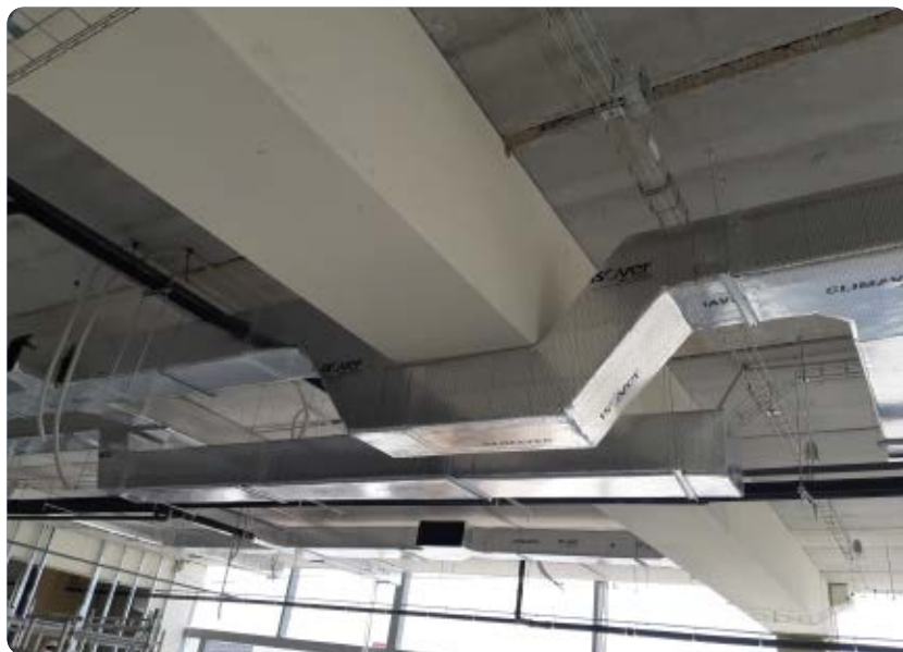
Instalación de conductos CLIMAVER®. Paso de viga MTR.
