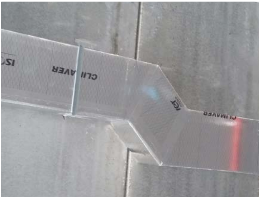
Instalación de conductos CLIMAVER®. Quiebro MTR.
