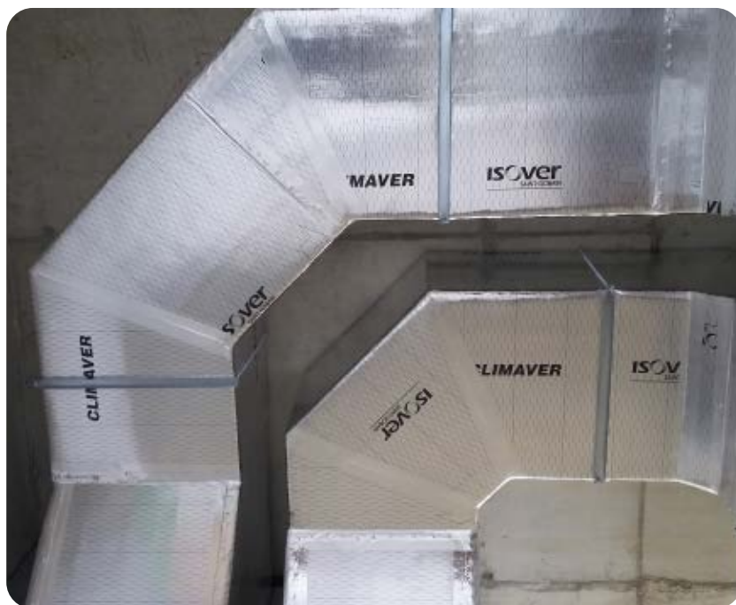
Instalación de conductos CLIMAVER®.
