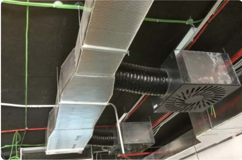
Instalación de conductos CLIMAVER®. Conexión a difusor mediante conducto flexible.
