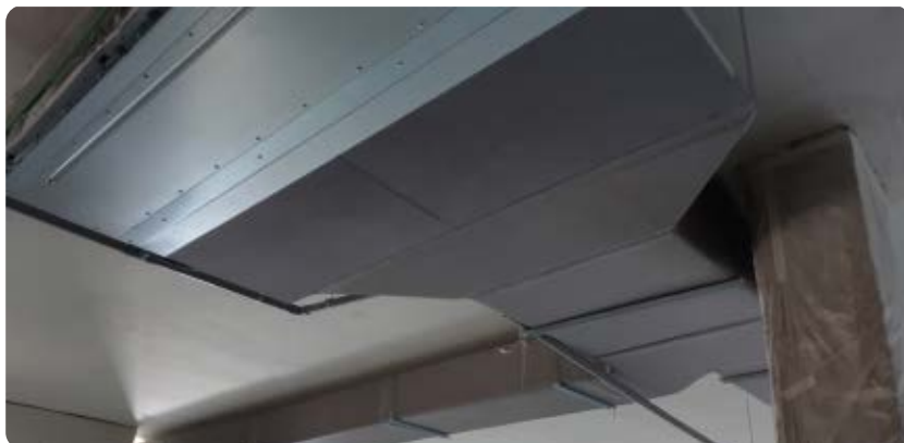
Embocadura a máquina instalación de conductos CLIMAVER® A2 deco.
