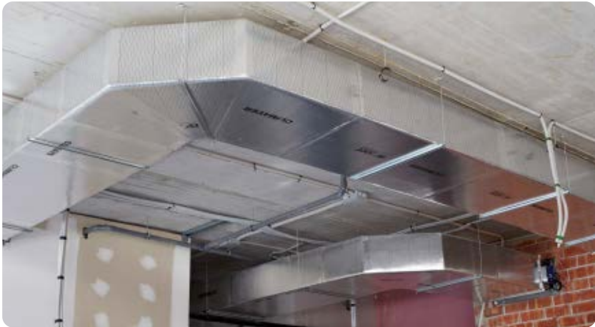
Instalación de conductos CLIMAVER®. Codo MTR.
