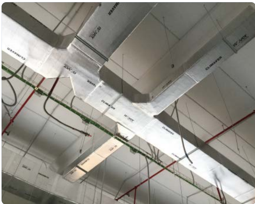
Instalación conductos CLIMAVER®. Zapato MTR.
