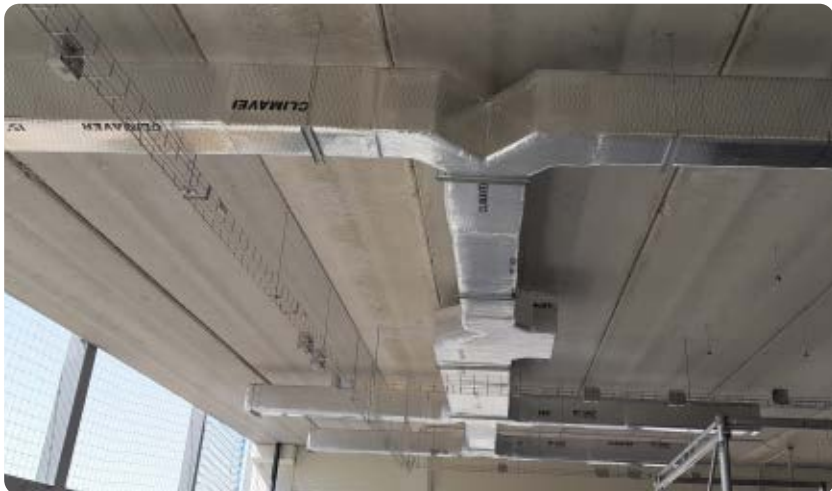
Instalación de conductos CLIMAVER®.
