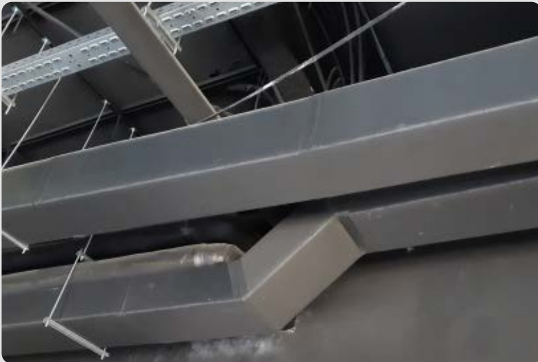
Instalación de conductos CLIMAVER® A2 deco. Quiebro MTR.
