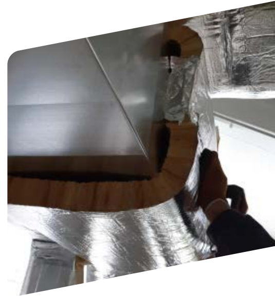
Sellado exterior del aislamiento con cinta de aluminio.
